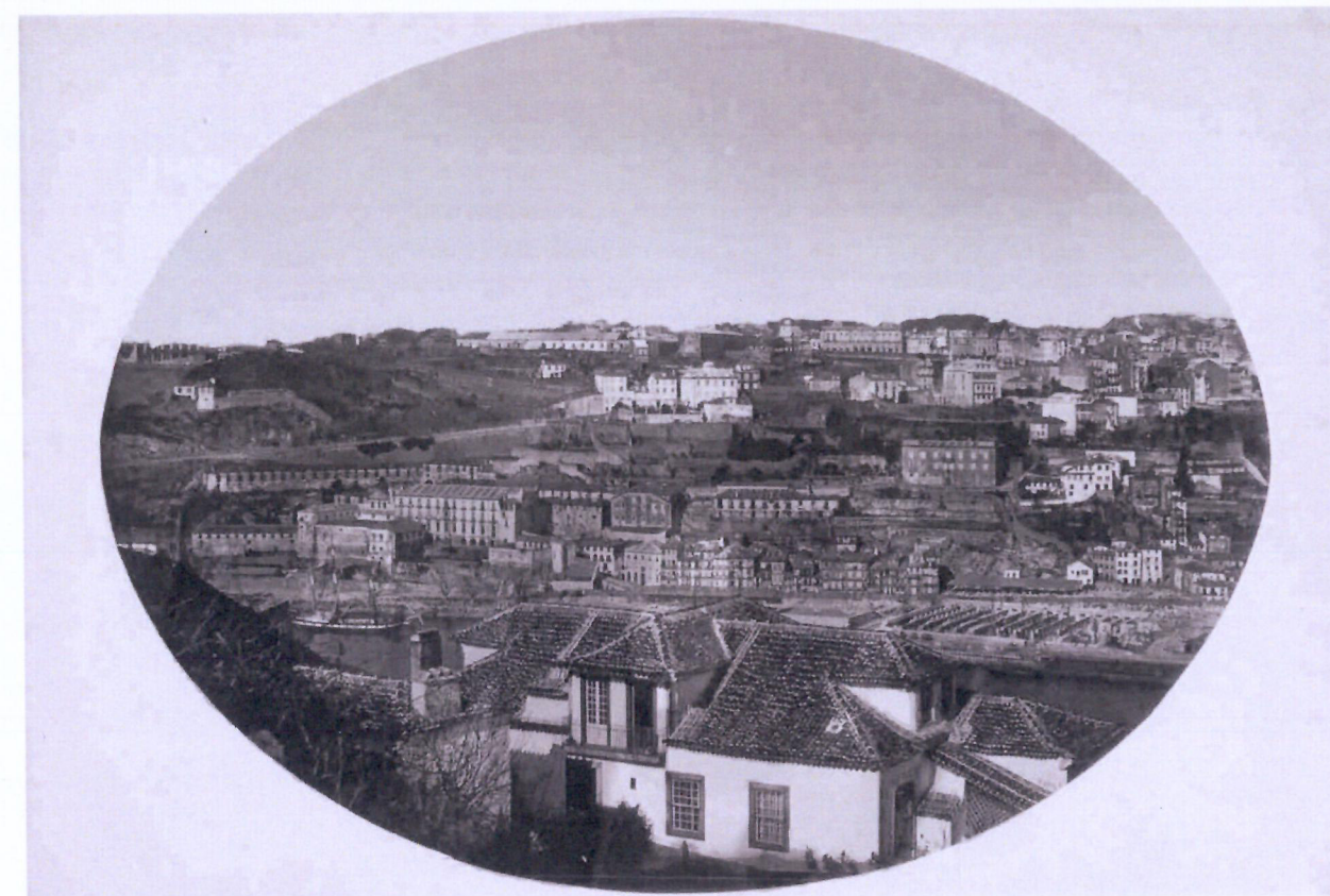
Início da construção da Alfândega
