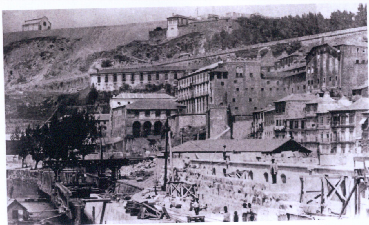
Construção da Alfândega Nova
